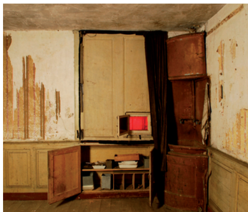
Dans le labo humide, trappe à lumière inactinique.
